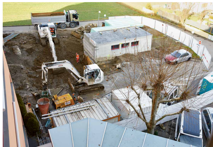
Baustelle, Sicht aus 4. OG
