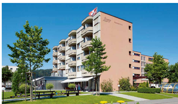
Ansicht von Osten
