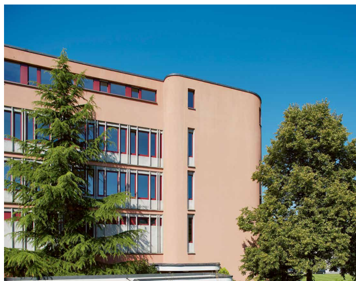
Teilansicht Gebäude Ostseite
