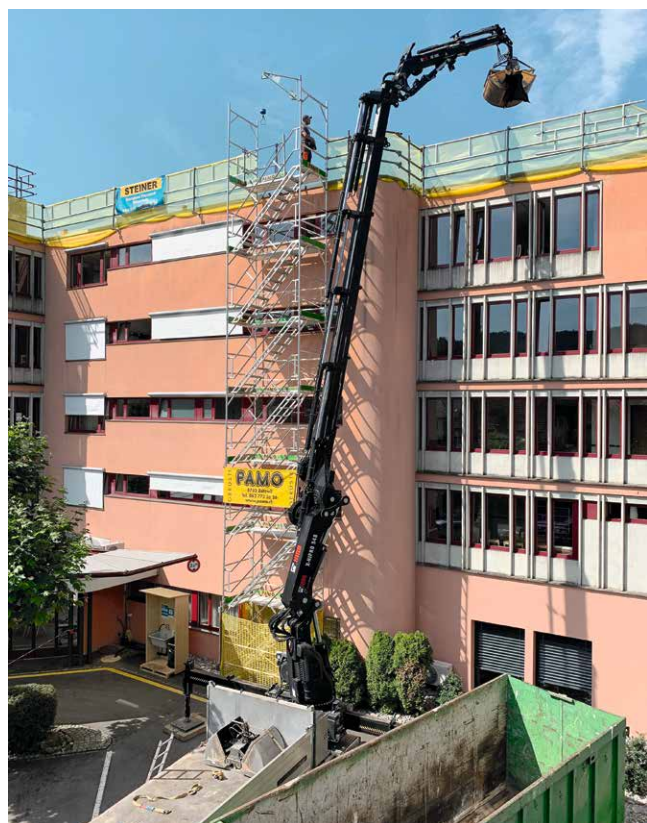
Rückbau vom alten Dach
