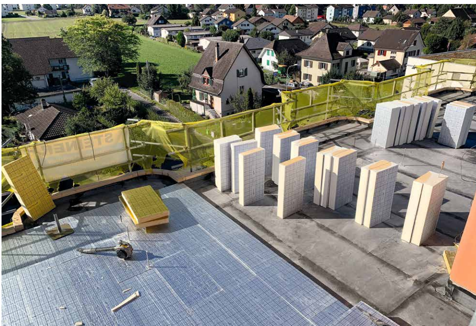
Verlegen von Isolationsmaterial
