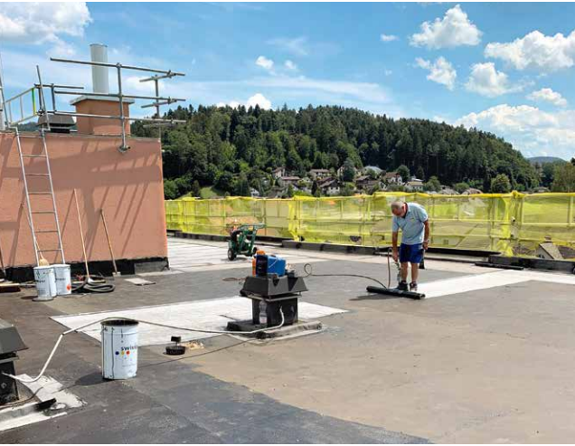
Verlegen einer Schicht auf dem Dach
